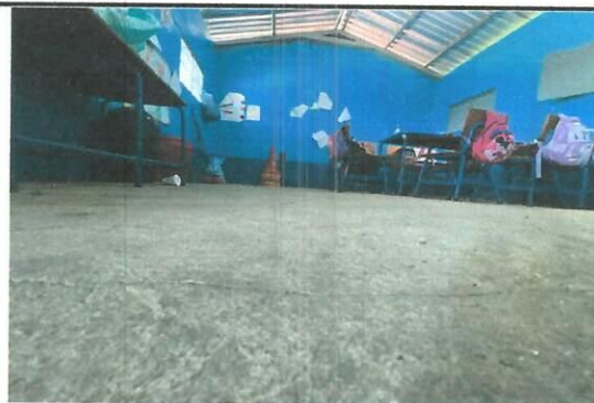
Foto 4: Área donde se colocará el piso.
