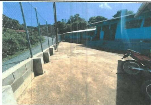
Foto 2: Área donde se colocará el entechado con lámina troquelada
