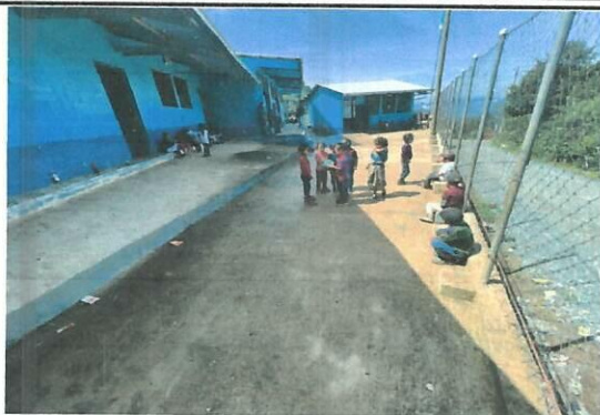
Foto 1: Área de patio escolar, estructura con pórtico metálico
